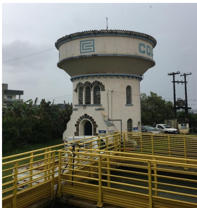
Figura 17 - REL ETA 1 (250 m³).
