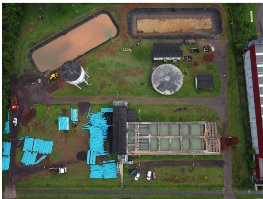
Figura 16 - Estação de Tratamento de Água ETA 2.
