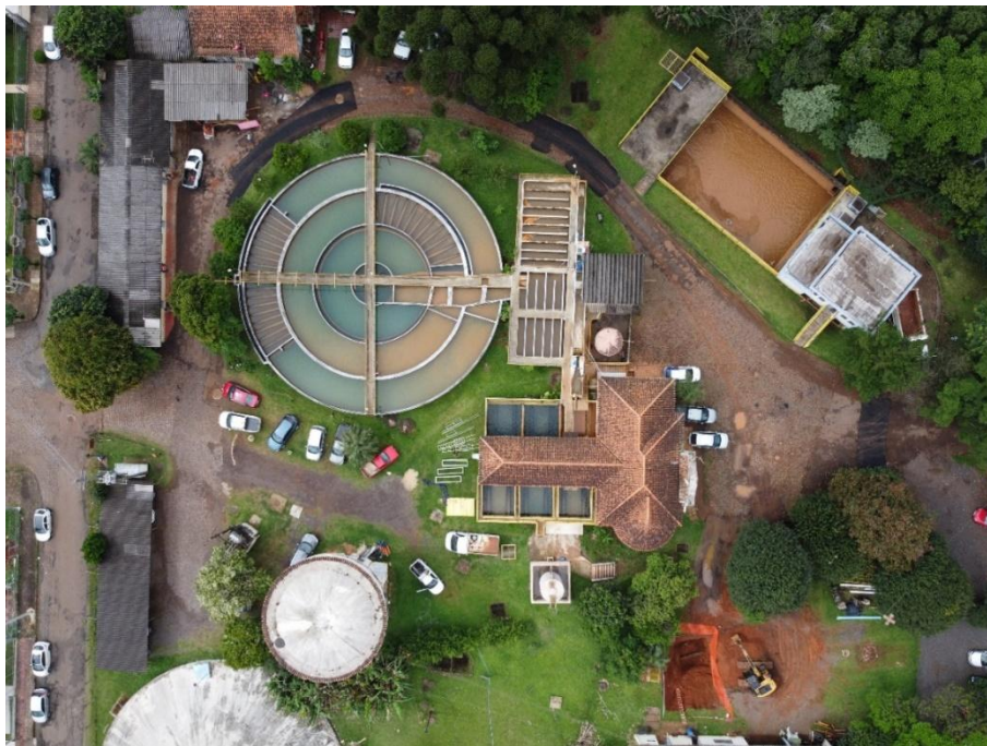
Figura 14 - Estação de Tratamento de Água ETA 1.
