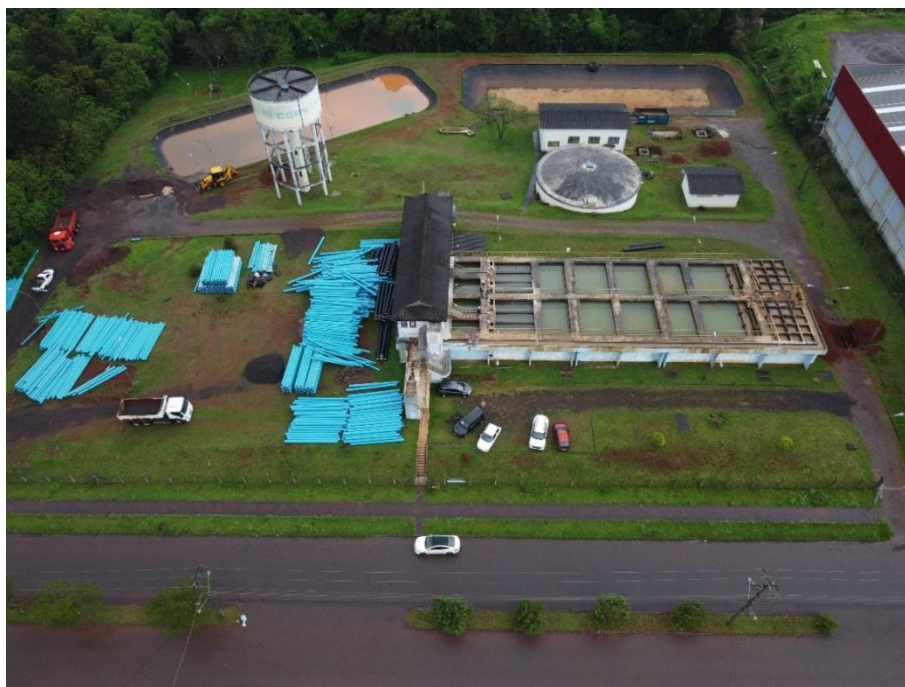
Figura 15 - Estação de Tratamento de Água ETA 2.
